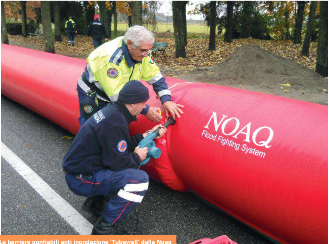
Le barriere gonfiabili anti inondazione 'Tubewall' della Noaq
