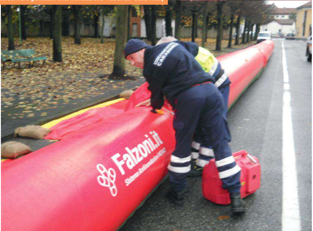
Le barriere gonfiabili anti inondazione 'Tubewall' della Noaq
