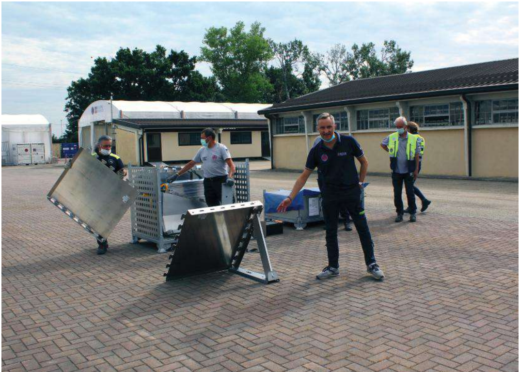
Le barriere anti esondazione in alluminio della svedese Inero. L'impermeabilità è garantita da grandi teli di plastica fissati al bordo della barriera
